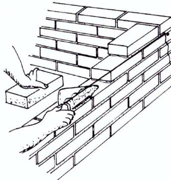
**Figura 7 - Colocação da argamassa de assentamento**
